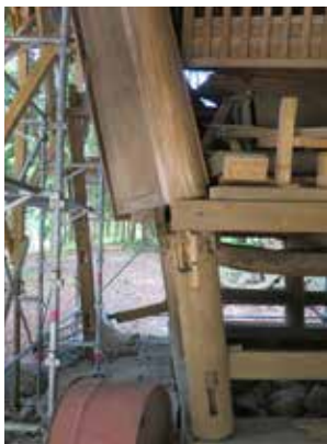
【本殿】倒壊した基礎石と滑動した躯体 【本殿】折損した隅柱 【本殿】軸組から脱落した屋根組
