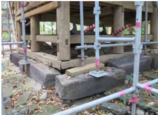
【本殿】倒壊した基礎石と滑動した躯体 【本殿】折損した隅柱 【本殿】軸組から脱落した屋根組
