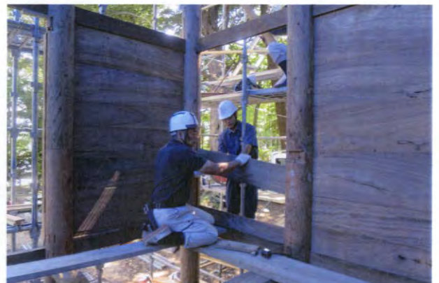
④ 落とし込み板を嵌め込む状況
