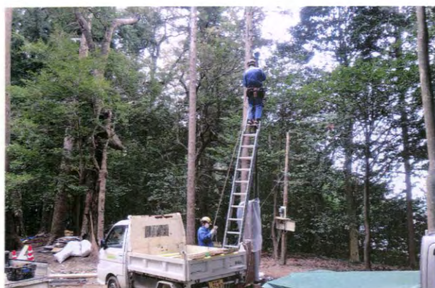
③ 防犯灯・自火報設備の新設
