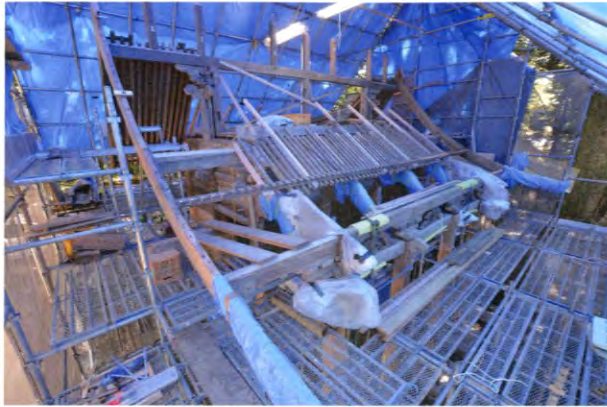
① 本殿正面、地垂木や破風の取付を完了
