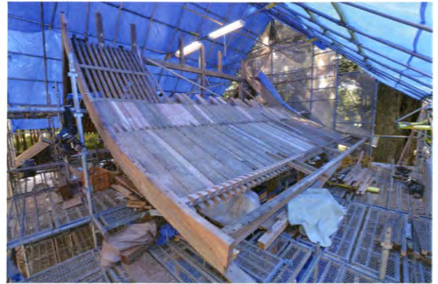
② 打越垂木とその化粧野地、軒先部材の取付け
