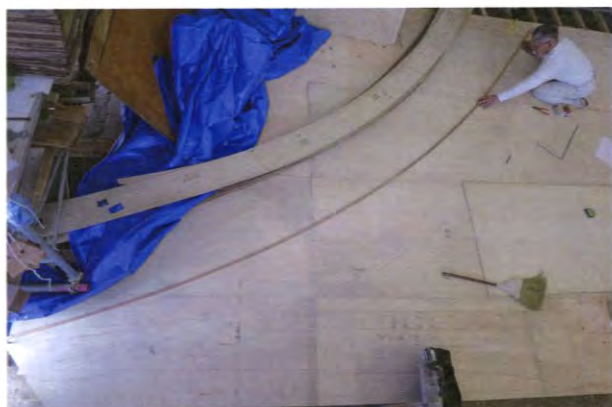
① 部材実測により小屋組の寸法体系を整理。屋根の弛み曲線を調整しました。
