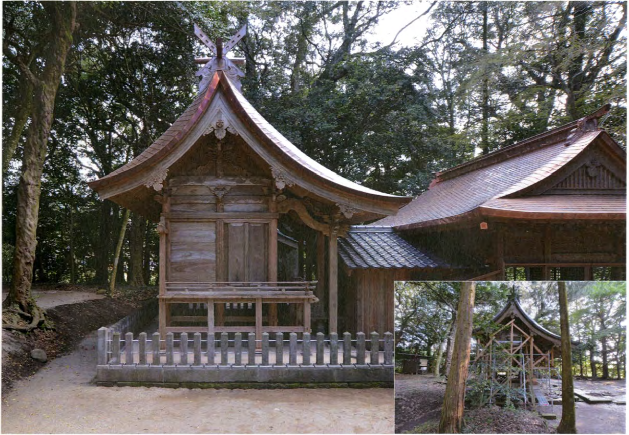
①・② 本殿北面 竣工と施工前
