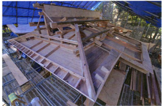
⑥ 屋根組施工状況 構造的一体性の確保
