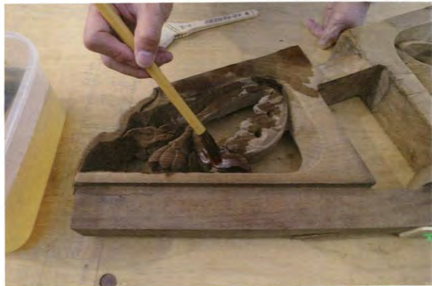
④ 表面劣化が進行したクスの彫刻部材に膠を含浸させました。
