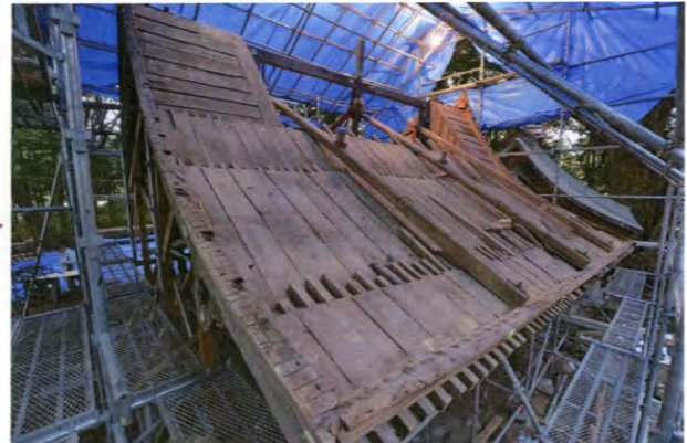
② 小屋組の解体完了。
