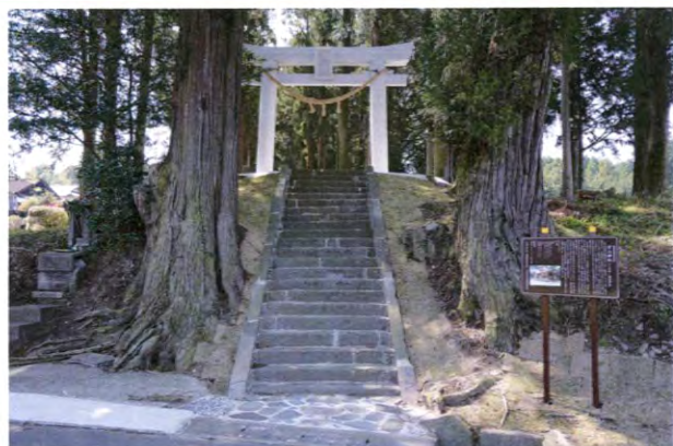
① 鳥居の再建と石段の積み直し
