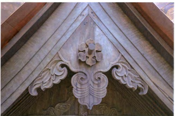
⑨ 懸魚の取付け。六葉と共に当初材を再使用した
