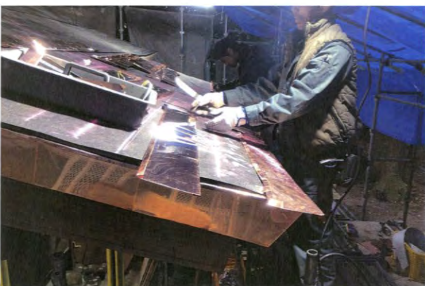
⑩ 銅板葺き施工状況
