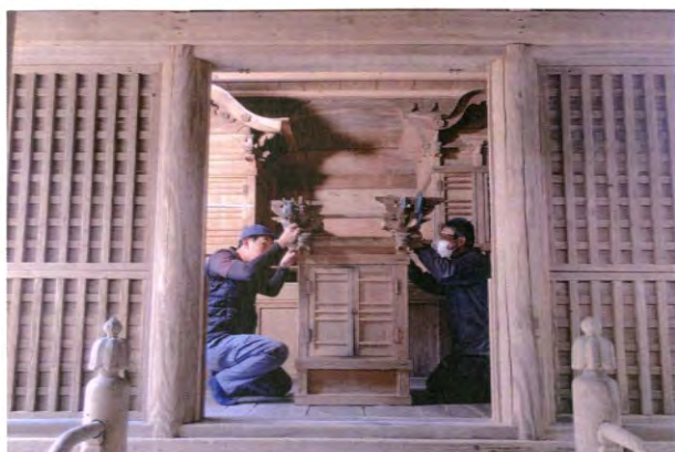
⑧ 空殿の補修と組立て
