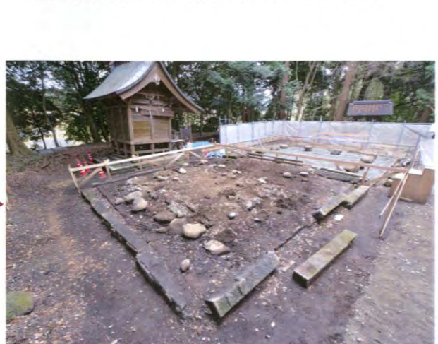
⑥ 基礎石まで解体を完了した状況
