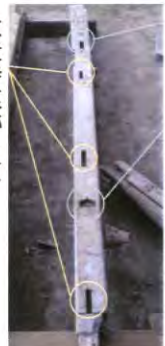
写真8：柱A本殿側に残る痕跡
