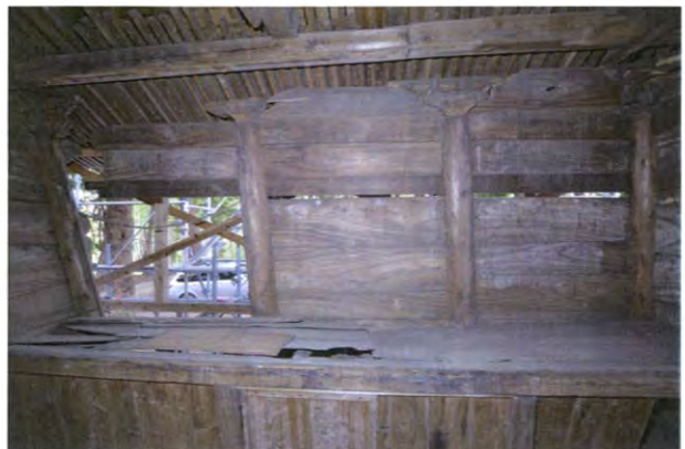
⑥ 本殿内部 施工前
