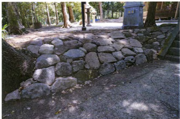
④ 境内に通じる石階段脇の石垣の積み直し
