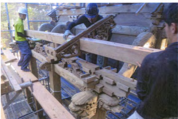
⑤ 向拝を組上げる状況。手挟みは桁の木口から差し込むつくりになっていました。
