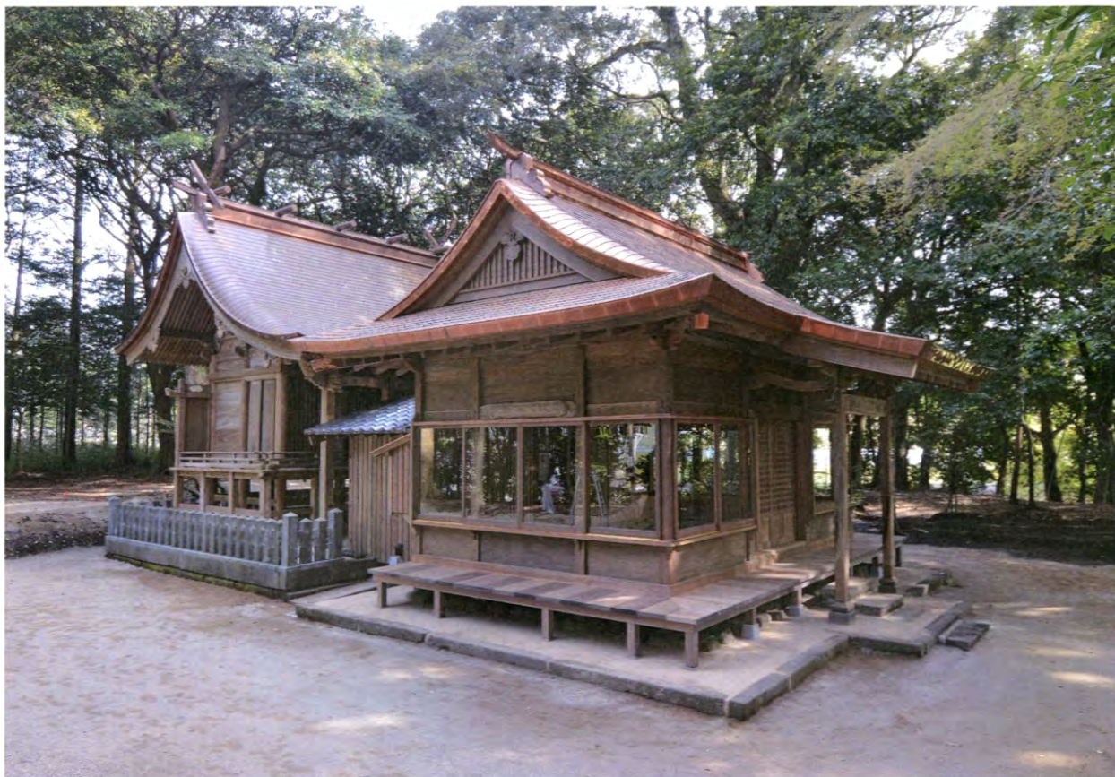
⑦ 3棟北西隅 竣工
