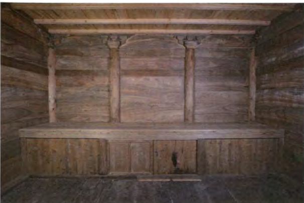
⑤ 本殿内部 竣工
