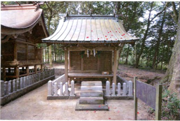
⑭ 雨宮神社西面 竣工
