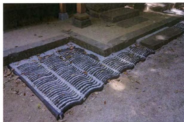
⑤ 古瓦を再利用して社殿周囲の雨落ちを整備
