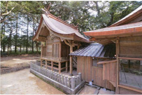
③ 本殿北西隅 竣工
