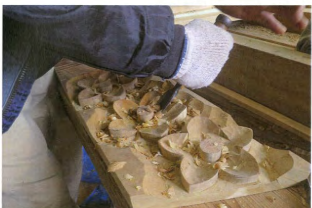
⑦ 彫刻部材の新規作成
