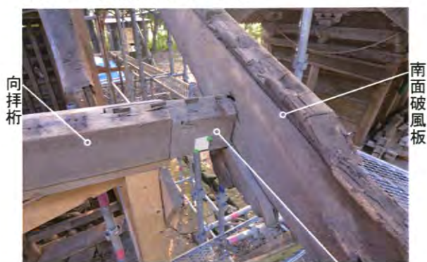
屋根改変時に付け足された桁 (転用材)
