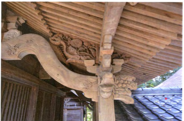
⑰ 本殿向拝 小屋組 竣工
