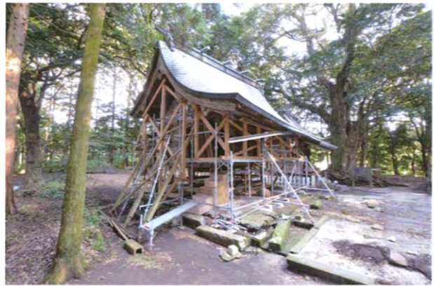
④ 本殿北西隅 施工前
