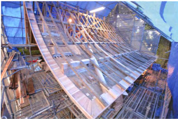
③ 補強材と桔木、垂木の取付完了
