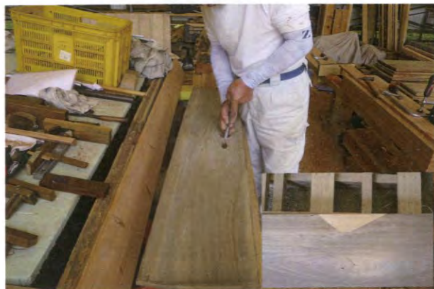
③ 板の割れや小さな欠けも丁寧に修繕しました。
