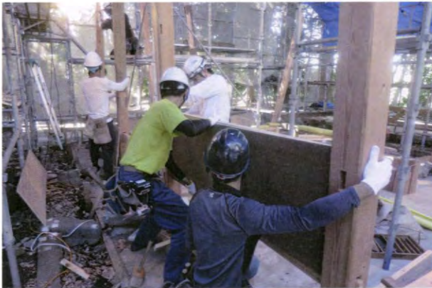
③ 軸組の組立工事 壁板と同時に建込
