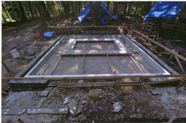
① 基礎工事を完了した基壇
