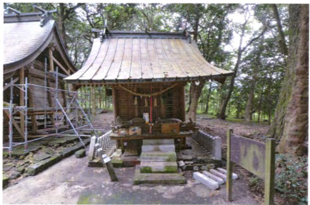
⑮ 雨宮神社西面 施工前
