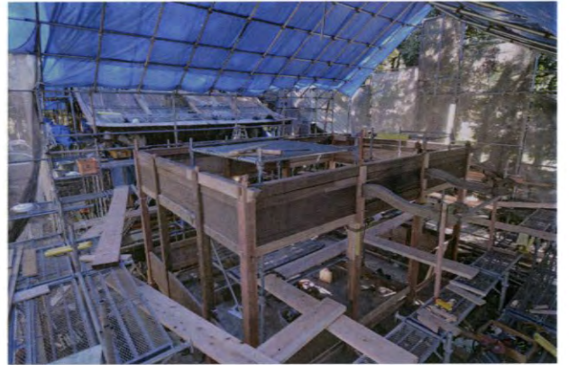
④ 軸部の組立状況 頭貫まで
