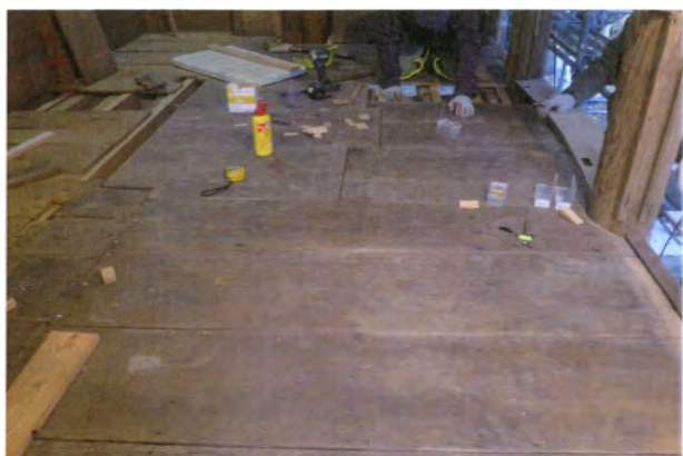
⑤ 本殿内部の床の復旧
