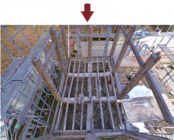
⑤ 床板や床組の解体状況。中央部に小火の痕がありました。幾多の苦難を乗り越えてきたようです。
