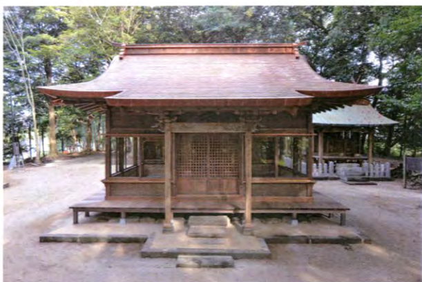
⑧ 拝殿西面 竣工
