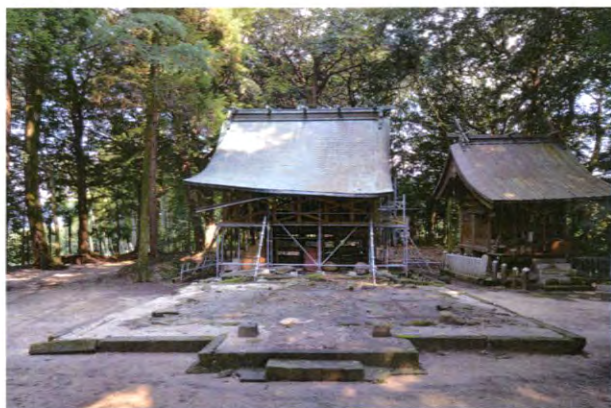
⑨ 拝殿西面 施工前
