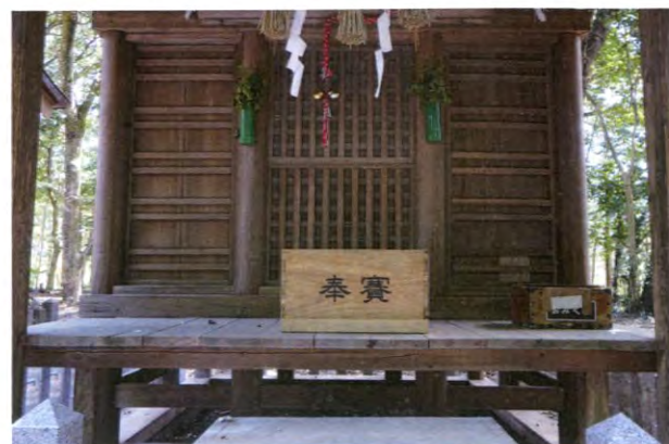
⑦ 雨宮の賽銭箱を修繕
