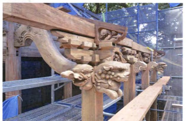
⑥ 組み上がった向拝の斗拱。発災時に倒壊した部分ですが、総ての材を再使用出来ました。
