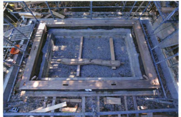
② 土台の据え付けを完了
