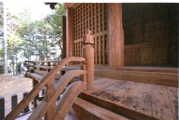
⑱ 本殿廻縁 擬宝珠付高欄柱 竣工
