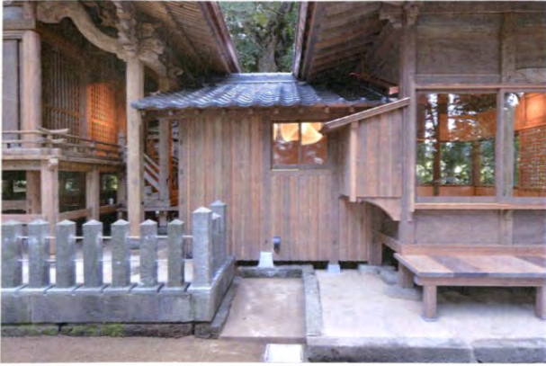
⑫ 幣殿南面 竣工
