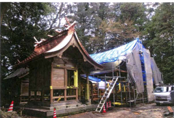
⑫ 足場・素屋根の解体
