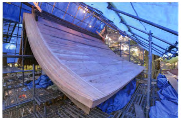
④ 荒野地の施工完了
