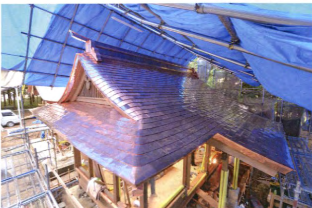
⑦ 屋根銅板の施工完了
