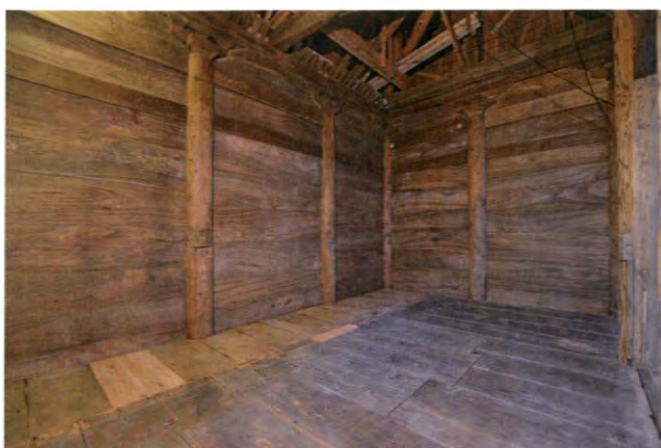
⑥ 本殿内部床復旧完了
