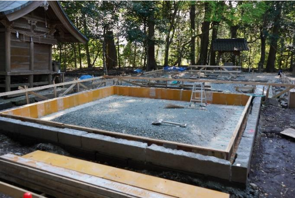
本殿・拝殿の基礎工事
