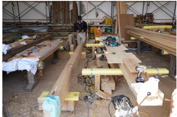
藤井棟梁による修復・新規の加工作業
