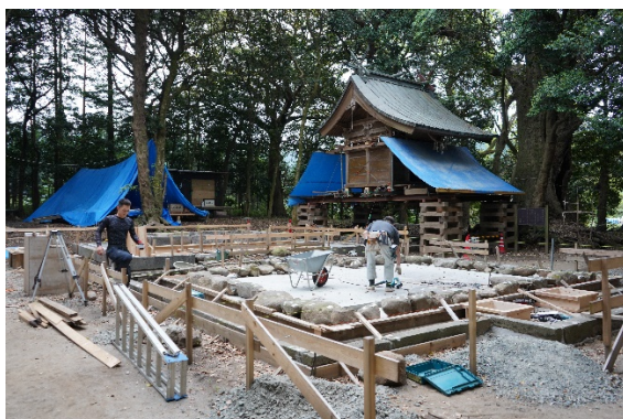
雨宮さんをジャッキアップして基礎工事
