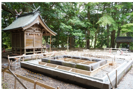
現在の基礎工事の状況と雨宮さん
