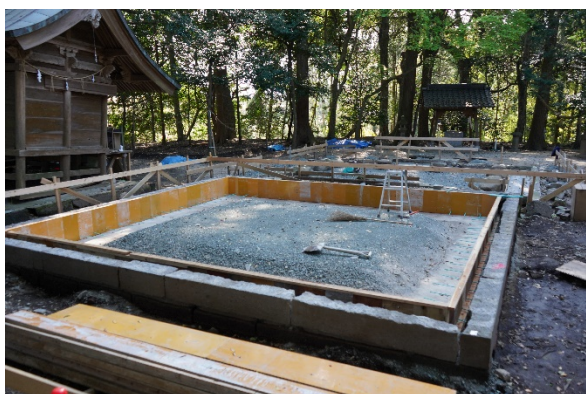
本殿・拝殿の基礎工事
